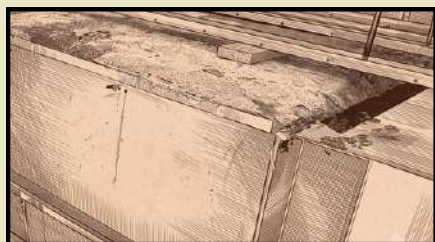
Béton sur toit & cotés
